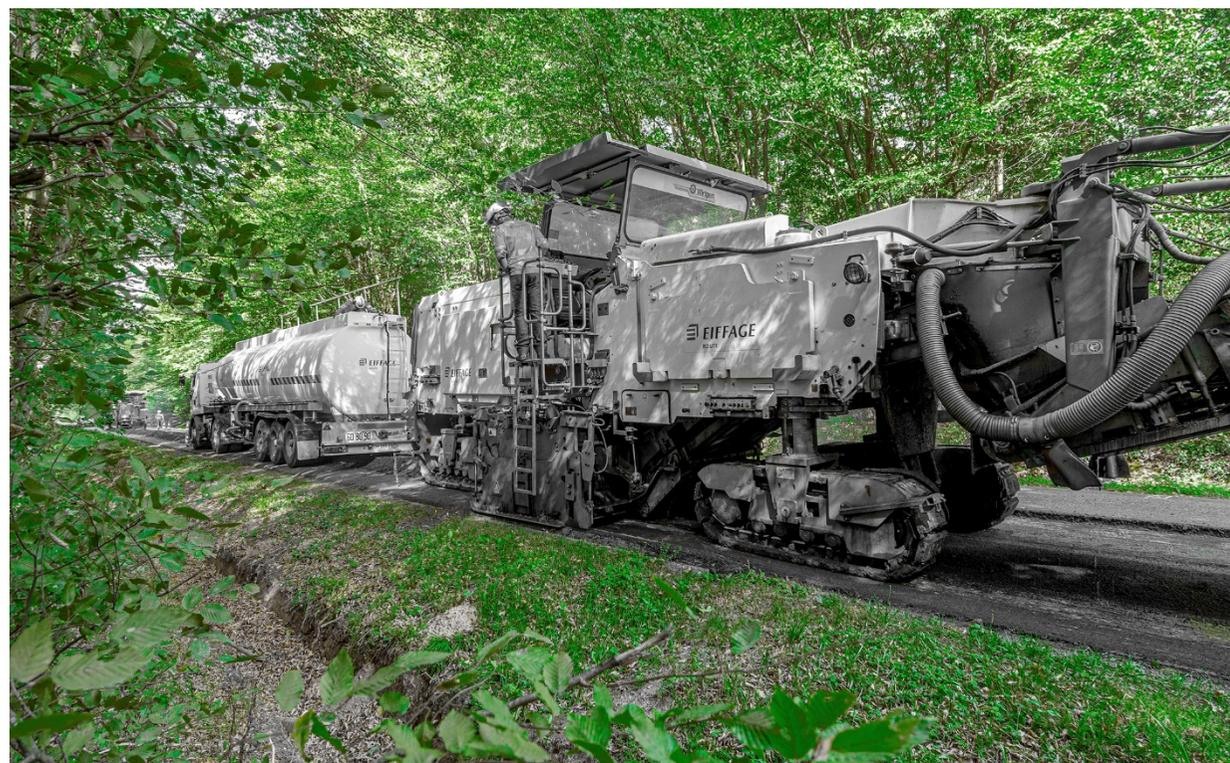
Chantier de rénovation de la RD96 (Seine-et-Marne), avec l'atelier de retraitement en place (ARM) permettant un recyclage intégral de la chaussée en place, associé au liant Recytaal®, labellisé biosourcé
